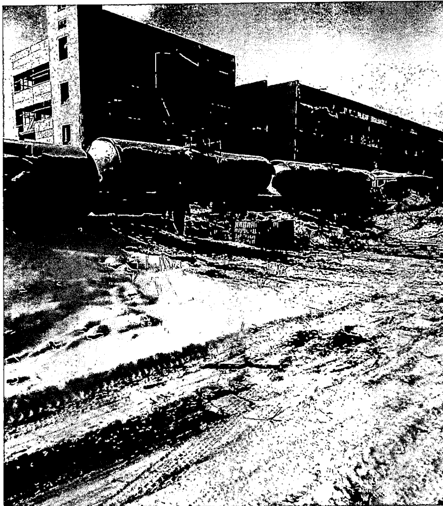
Емкости с опасными химическими веществами
