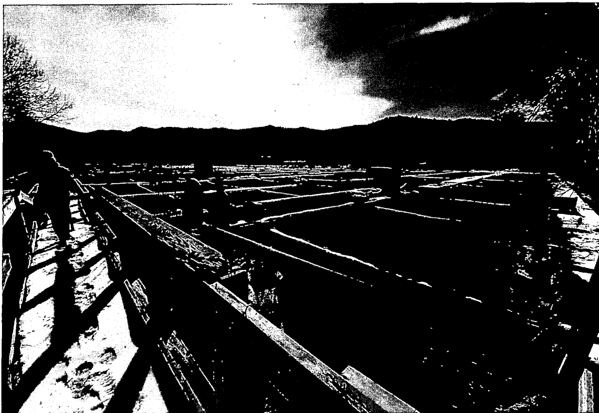
Полуразрушенные очистные сооружения ОАО «БЦБК»
