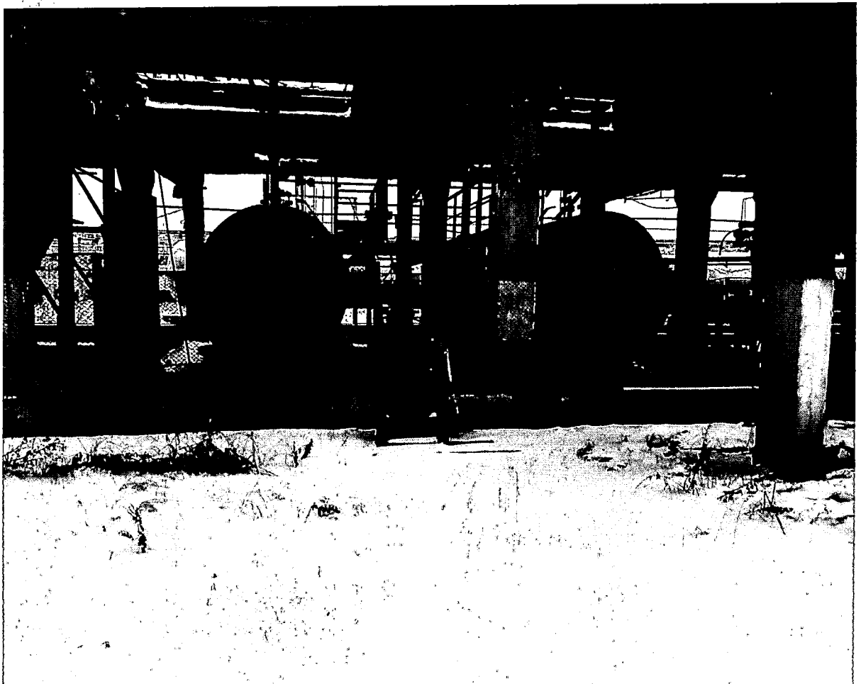
Емкости с опасными химическими веществами
