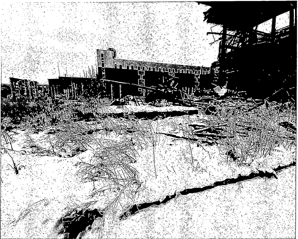
Полуразрушенные здания производственных цехов ОАО «Усольехимпром»
