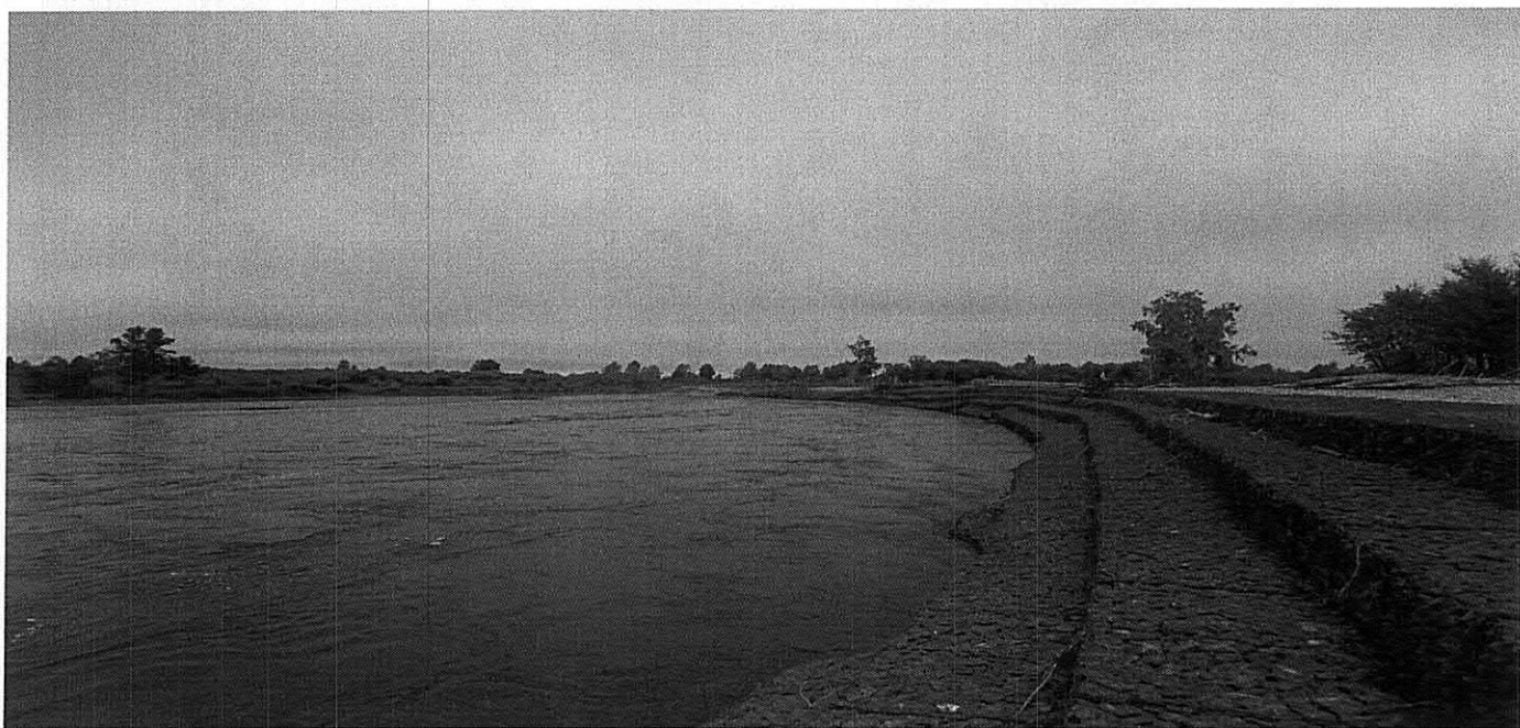
1. Фото «Берегоукрепление водозаборного узла на о. Черемуховый куст (р. Ока) в г. Зима»
