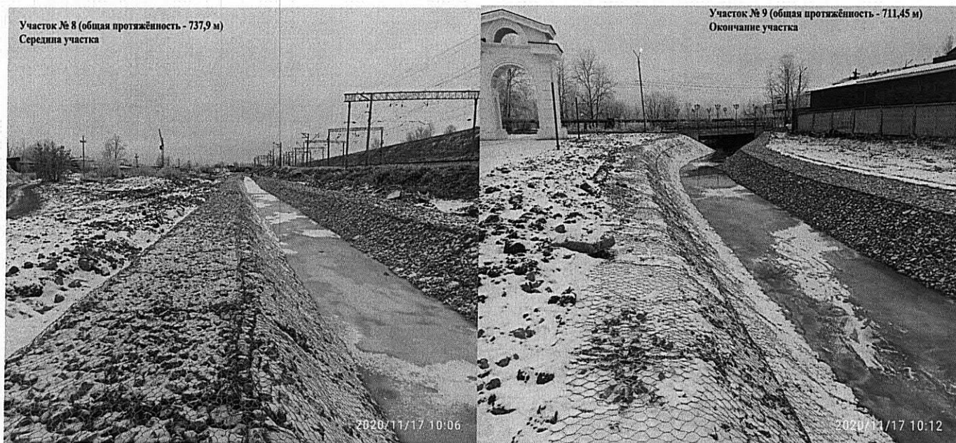
2. Фото «Строительство берегоукрепления реки Черемшанка в г. Черемхово»
