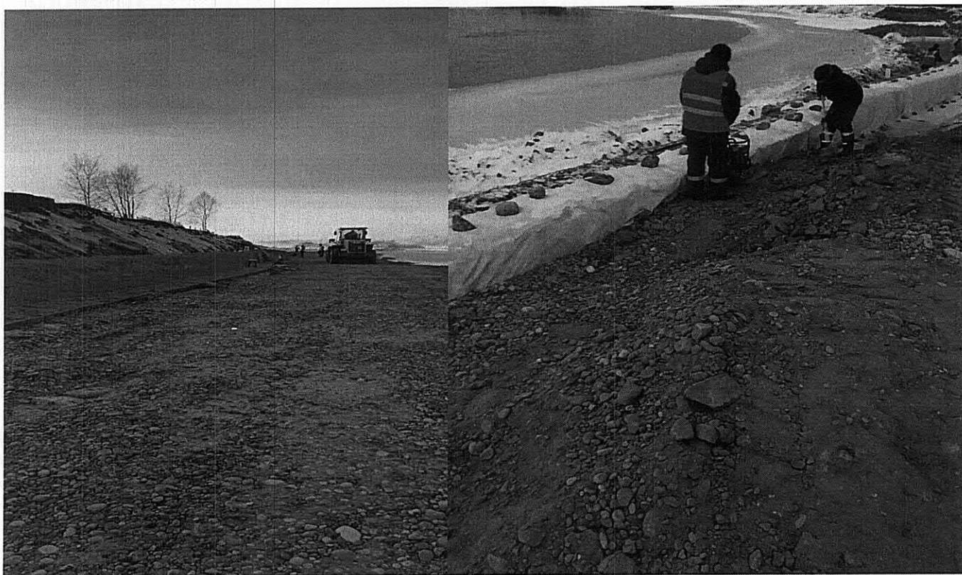
3. Фото «Строительство инженерной защиты с. Покровка Зиминского района от негативного воздействия вод реки Ока»
