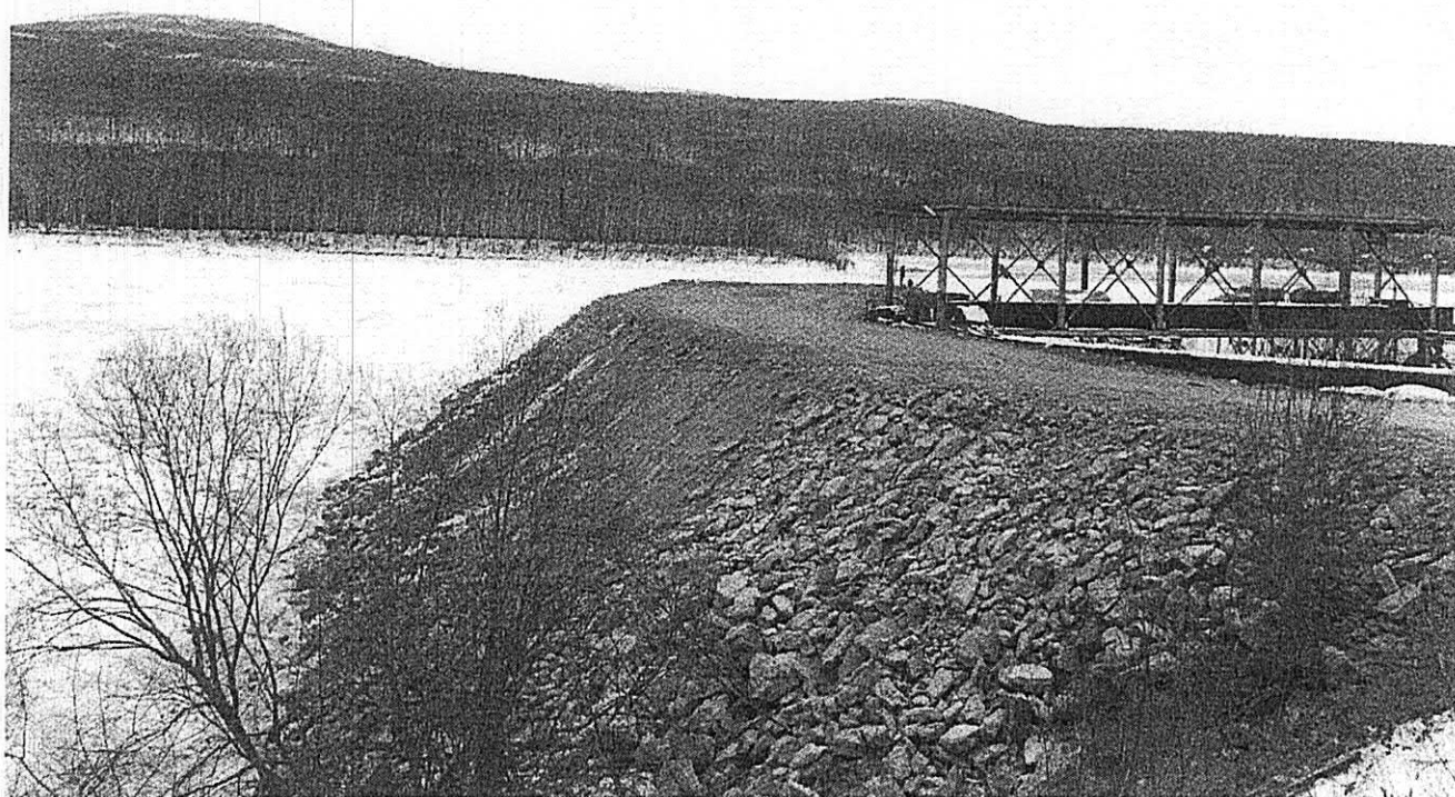
4. Фото «Капитальный ремонт защитной дамбы на р. Витим в г. Бодайбо»
