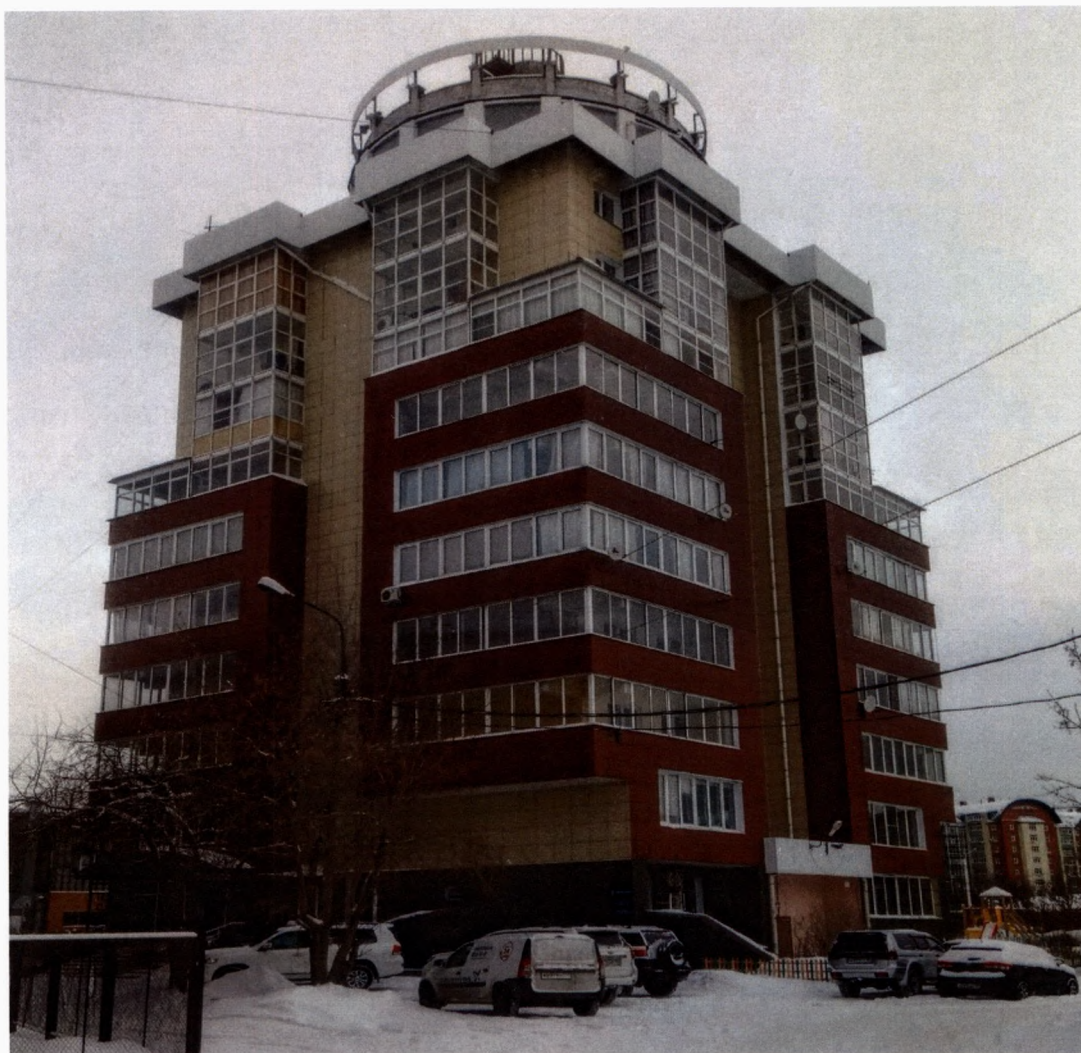
Фото 7. Многоквартирный жилой дом по адресу: г. Иркутск, ул. 4-я Советская, д. 48, возведенный с нарушением целевого использования земельного участка
