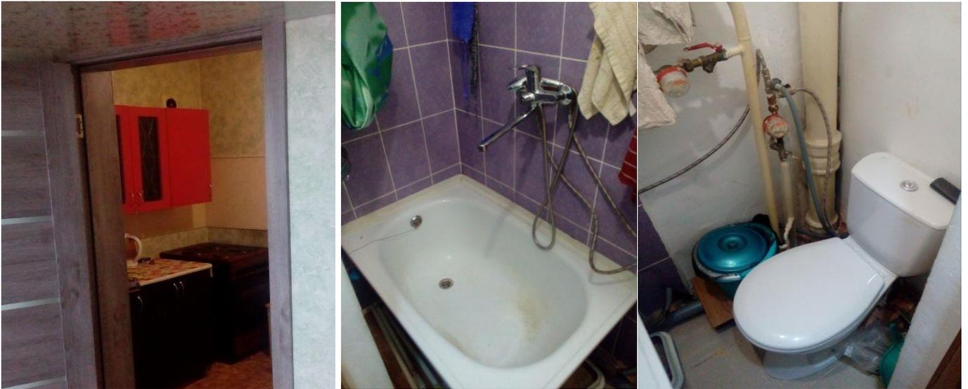
Аналогичные замечания по ненормативной площади санузла (2,6 м<sup>2</sup>) установлены при осмотре жилого помещения, приобретенного по адресу Зима, мкр. Ангарский, д.17, кв.90а. Кроме того, отделка стен в санузле выполнена из пластиковых стеновых панелей без устройства фартука из керамической плитки. В жилом помещении, расположенном по адресу г. Черемхово, пер. Пролетарский, д.4, кв. 28, отсутствует естественная вентиляция в кухне, покрытие пола из керамической плитки под ванной.
