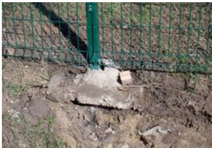
некачественно выполненные работы по установке ограждения «ГАРДИС»
