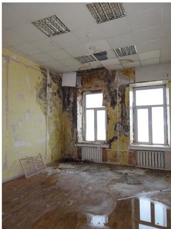
Фото 14-16. Фрагменты интерьера. Помещения 3-и 4 этажа. Протечки, биопоражения
