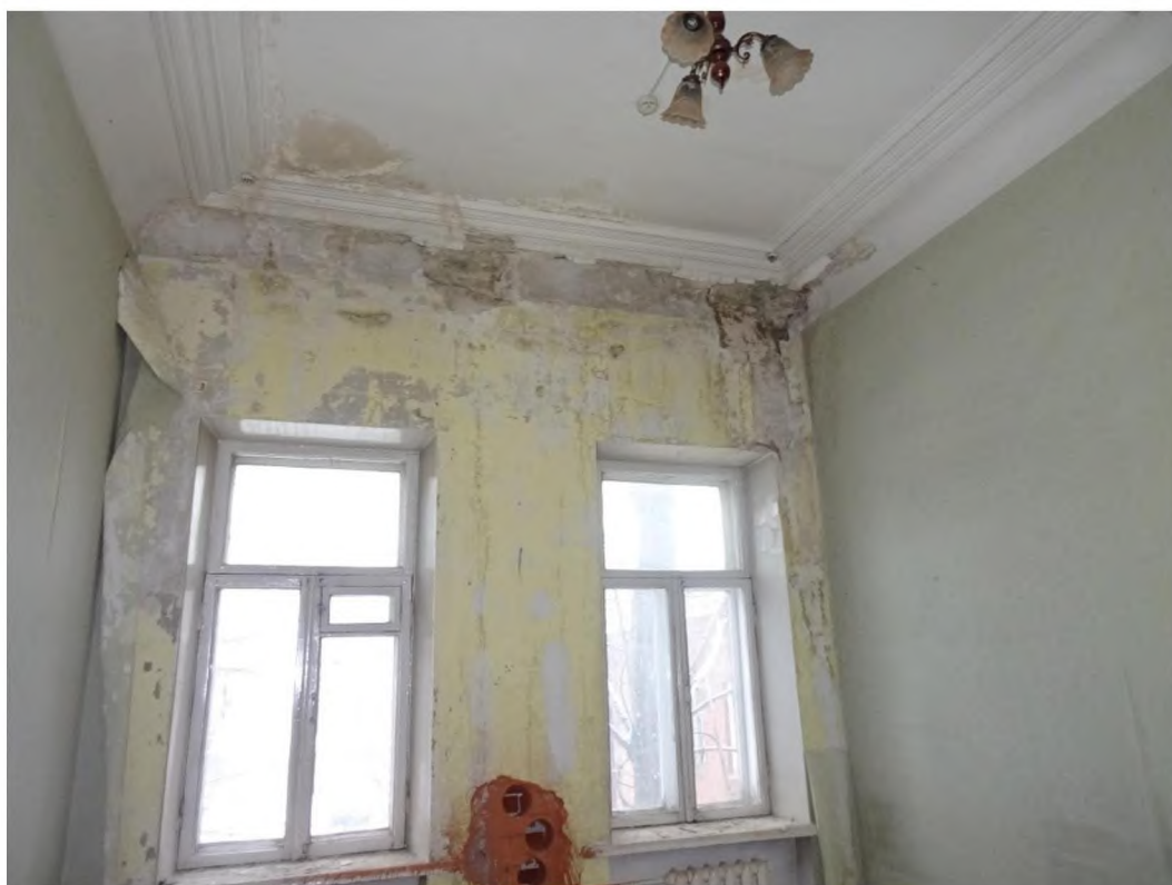
Фото 17-19. Фрагменты интерьера. Помещения 3-и 4 этажа. Протечки, биопоражения
