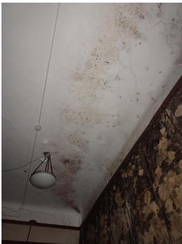
Фото 17-19. Фрагменты интерьера. Помещения 3-и 4 этажа. Протечки, биопоражения
