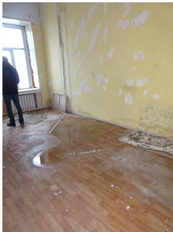
Фото 20-23. Следы замачивания, лужи на полу в помещениях.
