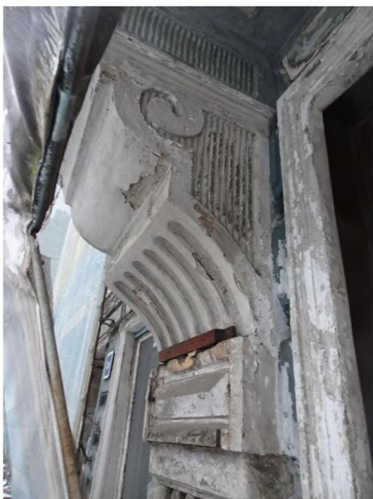
Фото 10-13. Главный (северо-западный) фасад. Вывалы штукатурки. Отслоение покрасочных и штукатурных слоев
