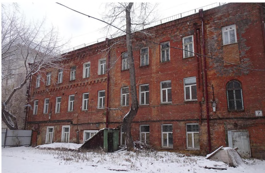
Фото 3. Дворовый (северо-восточный) фасад юго-западного корпуса. Фрагмент.
