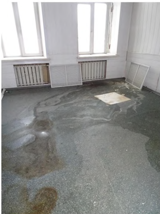
Фото 20-23. Следы замачивания, лужи на полу в помещениях.
