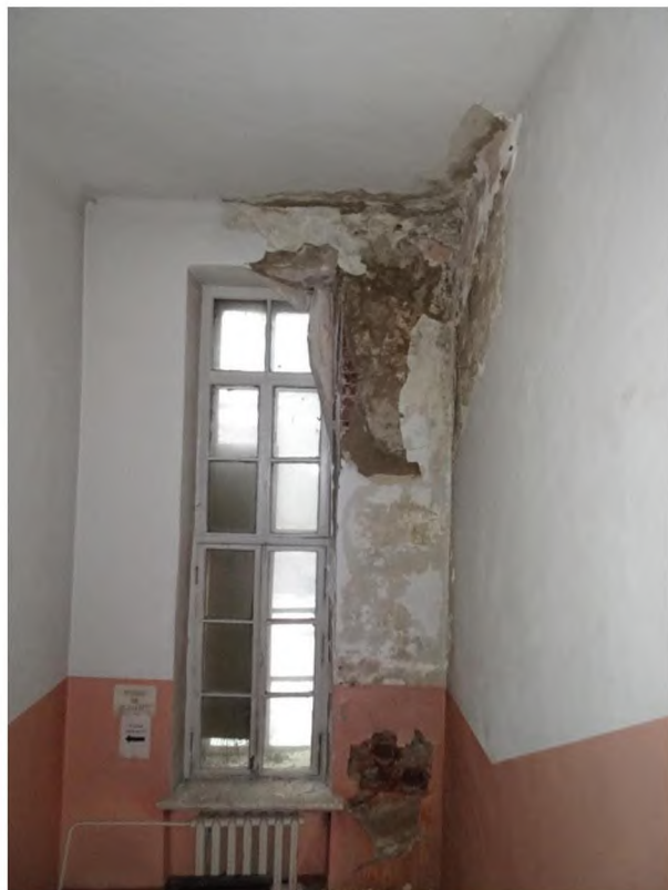
Фото 17-19. Фрагменты интерьера. Помещения 3-и 4 этажа. Протечки, биопоражения
