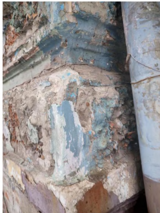
Фото 10-13. Главный (северо-западный) фасад. Вывалы штукатурки. Отслоение покрасочных и штукатурных слоев
