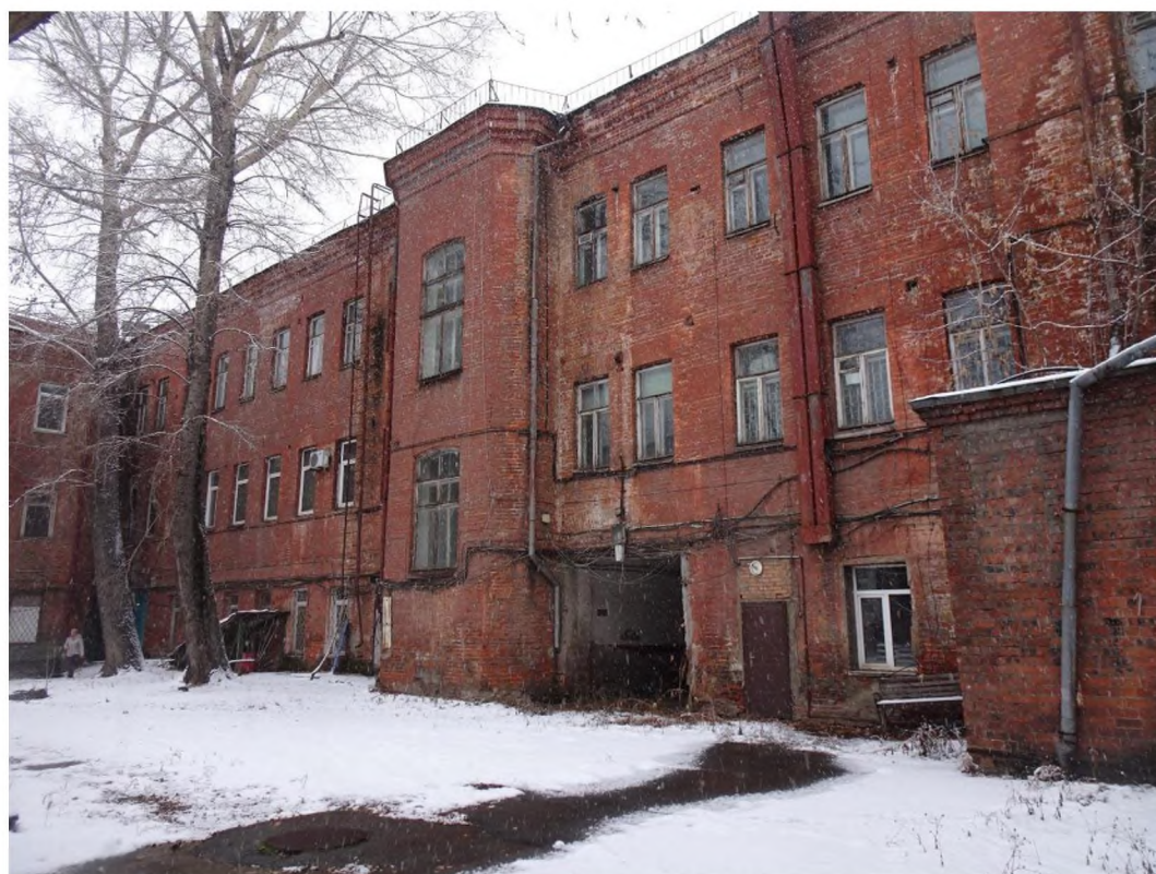
Фото 4. Фрагмент дворового (юго-восточного) фасада основного объема.
