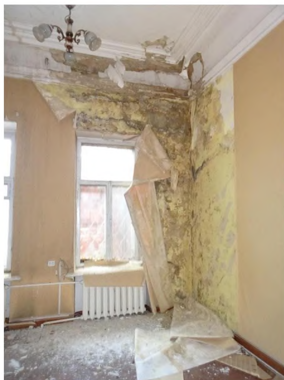
Фото 14-16. Фрагменты интерьера. Помещения 3-и 4 этажа. Протечки, биопоражения
