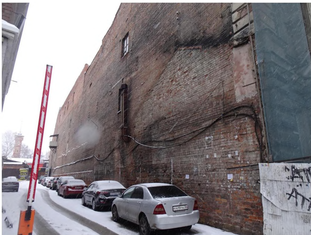
Фото 2. Боковой (северо-восточный) фасад.
